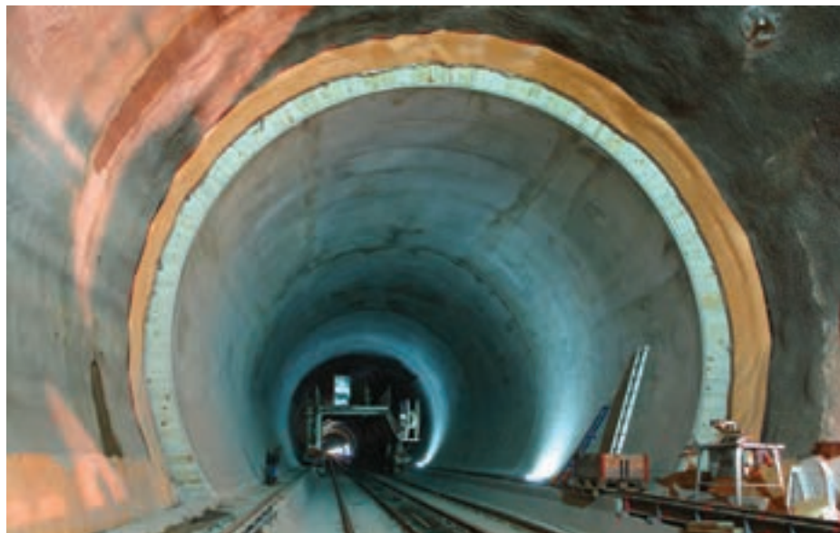
شکل ۴-۶- پوشش داخلی تونل به وسیله قطعات بتن
