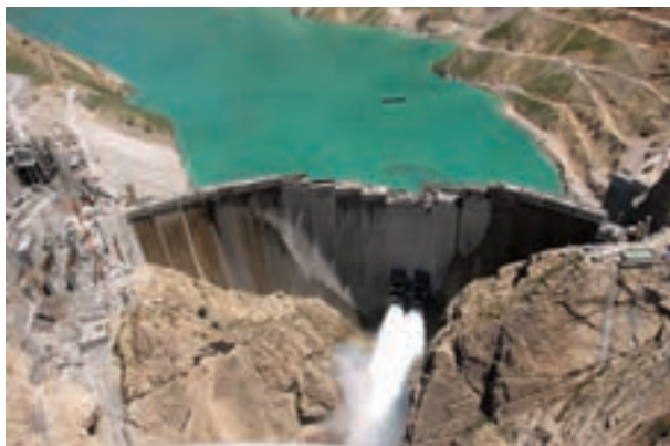
شکل ۶- سد کارون ۴ - خوزستان
